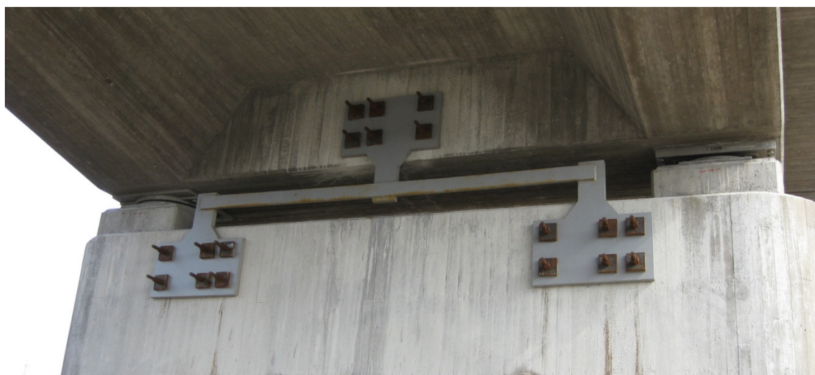
Figur 3. Anordning för låsning av Skäranbrons lager.
